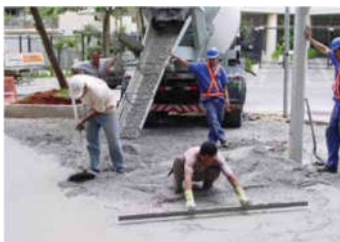
Figura 13 – Recebimento e espalhamento do concreto.
