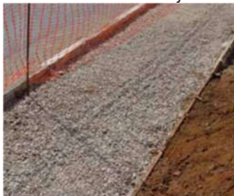
Figura 12 – Espalhamento da camada de Brita
